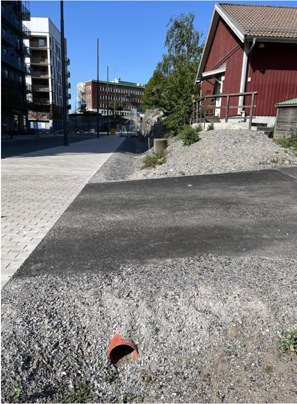
Figur 3 Dike längs fastighetsgräns vid Tor Boijes Gata (WSP 2023).
